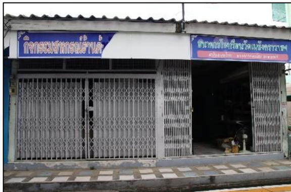
อาคาร อเนกประสงค์ งค์/โรง อาหาร/โรง ฝึกงาน/ หอประชุม 312 ปีที่สร้าง 2508
