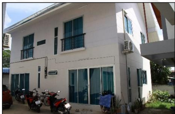
บ้านพักครู บ้านพักครู แบบ 204/61(ฝ) ปีที่สร้าง 2563
