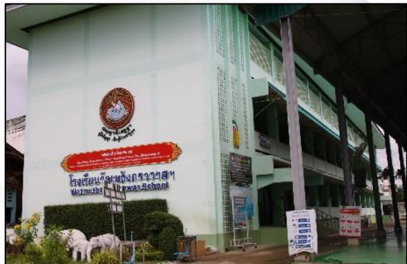
อาคารเรียน สปช.2/28 ปีที่สร้าง 2558
