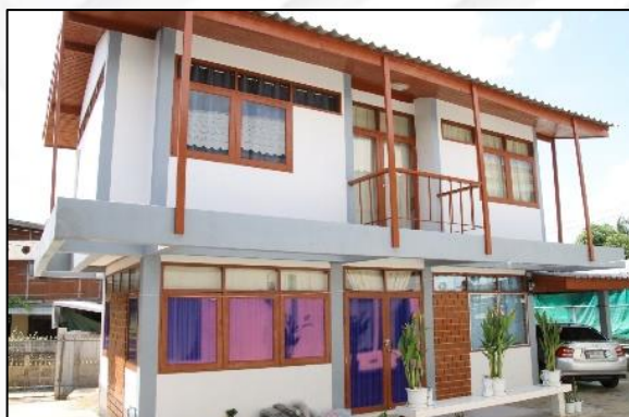
บ้านพักครู บ้านพักครู 207 ปีที่สร้าง 2564
