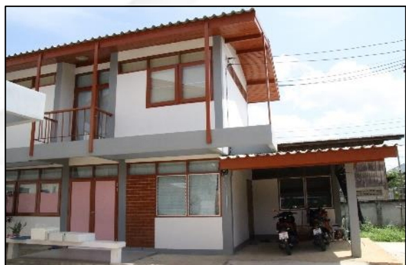
บ้านพักครู บ้านพักครู 207 ปีที่สร้าง 2564
