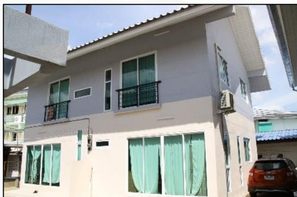
บ้านพักครู บ้านพักครู แบบ 204/61(ฝ) ปีที่สร้าง 2564
